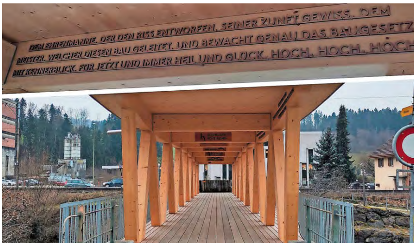
Der Richtspruch ist prominent an der neuen Holzbrücke in Dillhaus angebracht und ziert die gesamte Länge. Fotos Bildkombi: Bettina Schnider
